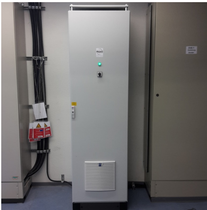
Bild 1: OSFS-V Aktives Filtersystem - arbeitet spannungsgeführt, ohne Stromwandler
